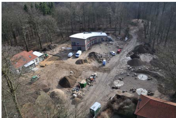
Blick auf die Baustelle vom Fernsehturm aus
