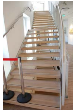
Treppe zum OG
